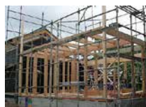
プレカット材住宅建設風景
