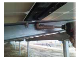
使用作業風景
