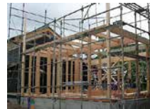
プレカット材住宅建設風景
