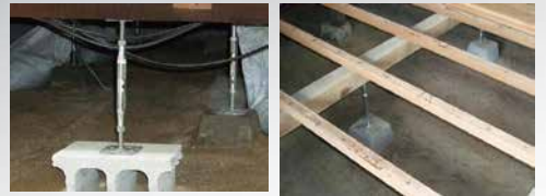
鋼製束及びターンバックルの調整
