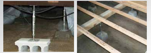
鋼製束及びターンバックルの調整
