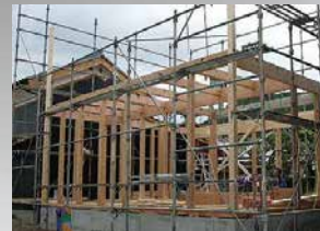
プレカット材住宅建設風景
